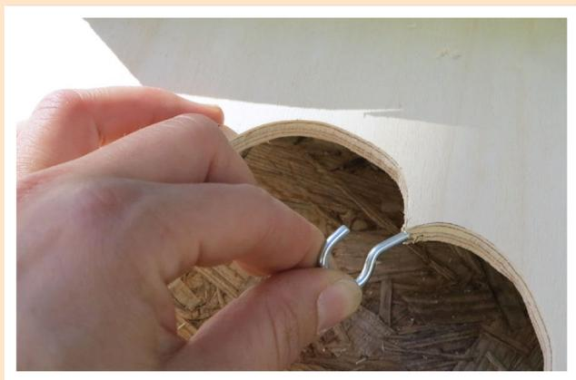
**02** Schraube die Ringschraube von oben in die Spitze des Daches. Daran kannst Du später Deine Vogelfutter-Station aufhängen.
