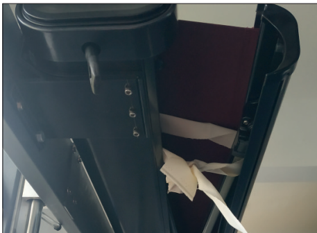
4. Säkra de fjäderbelastade armarna med remmar för att undvika att de slår ut.
