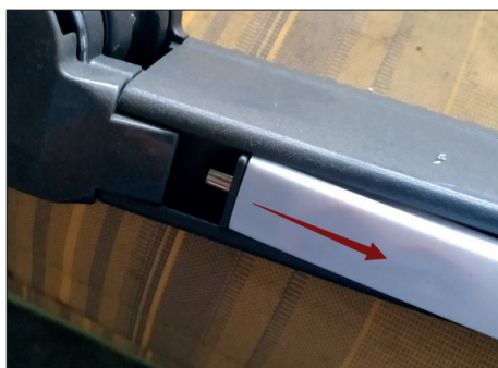
5. Lossa LED-rören från bjälkarna.
