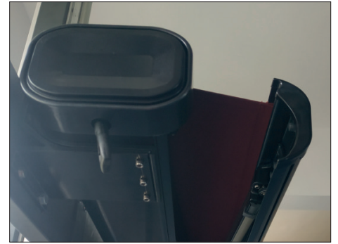
3. Déployer une petite longueur de tissu en faisant tourner l'œilleton de manivelle.
