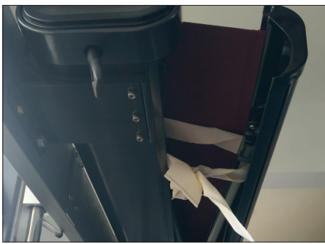
4. Fixer les quatre bras à ressort du store à l'aide de bandes pour les empêcher de se fendre.
