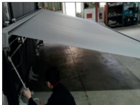
**1.** Trennen Sie die Markise vom Netz und öffnen Sie diese mit der Handkurbel, oder trennen Sie sie im ausgefahrenen Zustand vom Netz.
