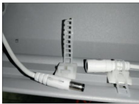
**4.** Öffnen Sie die Kabelhalter der LED Streifen in den Gelenkarmen und trennen Sie die Steckverbinder zum Ausfallprofil.
