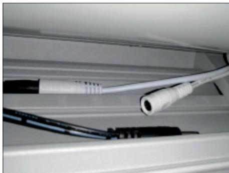
**2.** Koppla bort ledningskontakterna inuti huven och LED-remsorna i armarna.
