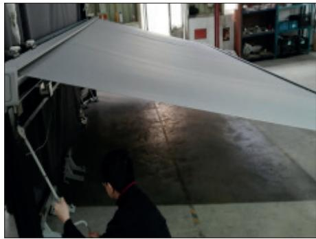
**1.** Vypněte zdroj energie a použijte ruční kliku na otevření markýzy , nebo markýzu otevřete elektrickým ovládáním a potom jej vypněte.
