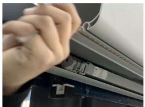
**9.** Ziehen Sie den LED Streifen aus dem Ausfallprofil.
