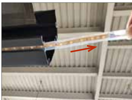
10. Tirer lentement la bande LED hors de la rainure dans la barre avant.
