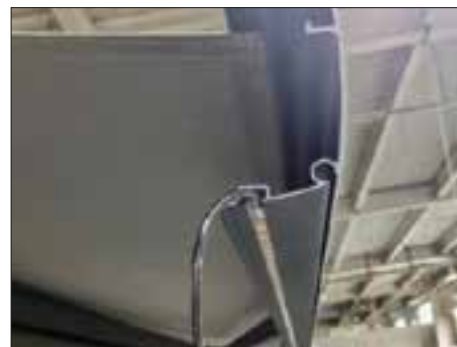
9. Ta ut LED-remsan från LED-hållaren i frambjälken.
