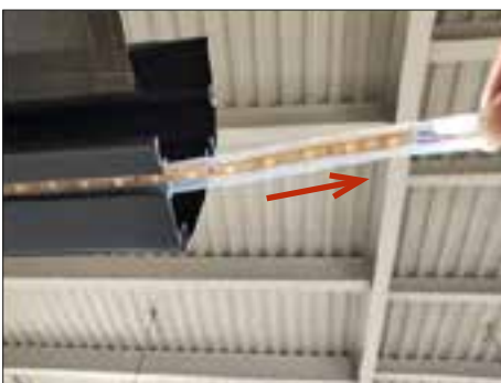
10. Trek de LED-strip langzaam uit de groef in de voorbalk.
