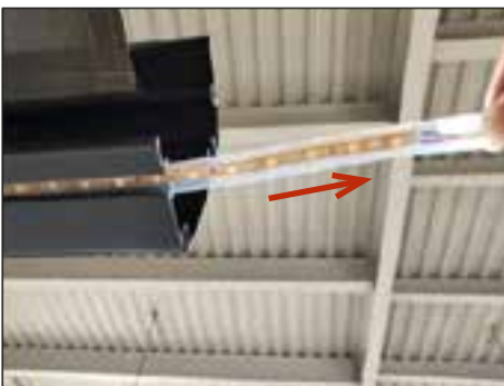
10. Ziehen Sie den LED Streifen langsam aus der Nut im Ausfallprofil.
