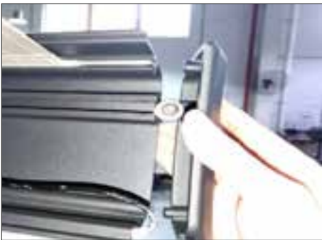
4. Nehmen Sie die seitlichen Abdeckungen des Ausfallprofils ab.
