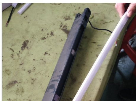
4. Opatrne vytiahnite LED žiarivky z dlhých nosníkov.
