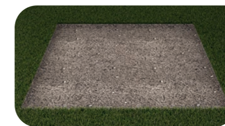
Rasenfläche ca. 10 cm tief ausheben und ebnen.
