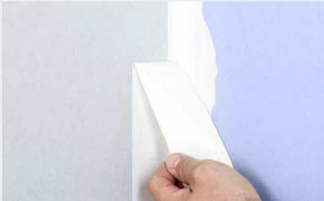
8. Überstehenden Streifen abziehen.
