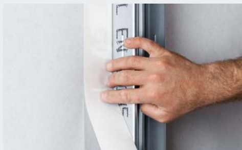
2. Knauf Trenn-Fix im Bereich des Bauteil-Anschlusses auf das anzuschließende Bauteil (z. B. Putz, Beton, Holz, Trockenbau usw.) aufkleben.
