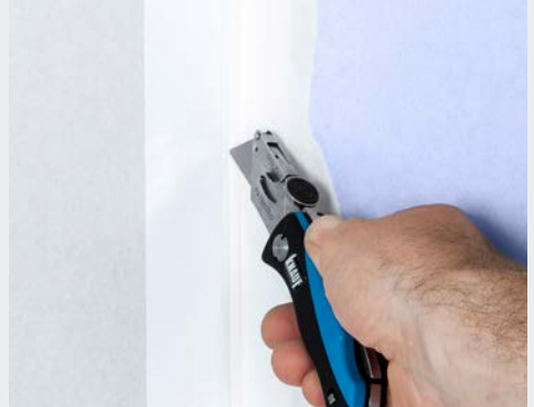
7. Nach Trocknung und Schleifen Trenn-Fix in der Ecke einschneiden.
