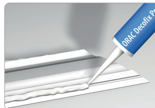
Den Montagekleber auf die Eckleiste auftragen
