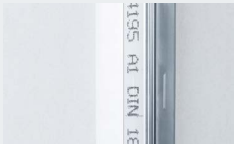
4. Trenn-Fix andrücken und glatt streichen.
