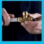
Schritt 4: Rohr einstecken
