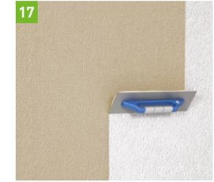
Oberputz auftragen und im Anschluss strukturieren.
