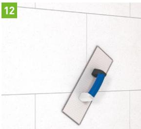
Versatzstellen ca. 30 Min. nach dem Verkleben beischleifen.
