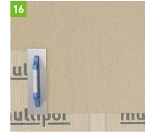
Mit leichtem Druck etwa 2 mm in die Armierungsschicht einbetten.
