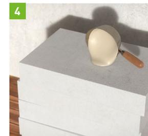
FIX X710 auf die Rückseite der Dämmplatte auftragen.
