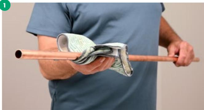
Die Rohrleitung zunächst von Staub, Schmutz, Öl und Wasser befreien.
