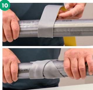
10 Um Kältebrücken zu vermeiden, die Rohrschellen mit dem CLIMATUBE® PE Wickelband umwickeln.
