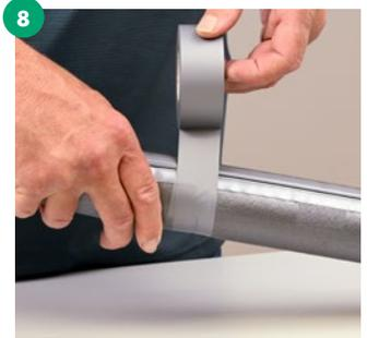
8 Querstöße sind fugenfrei mit dem CLIMATUBE® PVC Klebeband zu sichern. **Das Band überlappend in 2-3 Lagen anbringen und dabei fest andrücken.** Alle Oberflächen müssen trocken, staub- und fettfrei sein
