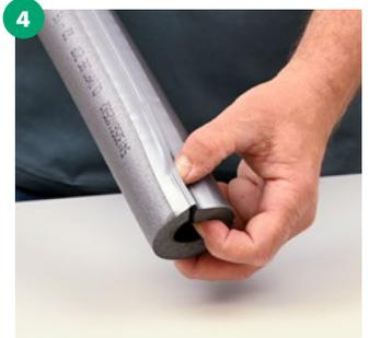
4 Den Zip-Verschluss der Länge nach öffnen und anschließend die Dämmung über die zu isolierende Rohrleitung stülpen.
