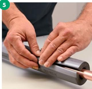
5 Den Zip-Verschluss anschließend wieder der Länge nach verschließen.
