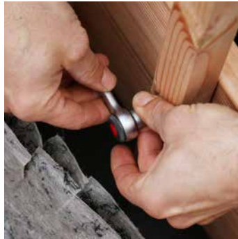
2. Die beiden langen Pfosten innen an die Gefäßwand schrauben
