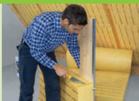
Leichtere, sauberere Schnittführung, ebene Schnittfläche und bessere Formzuschnitte an Traufe, Kehle etc.
