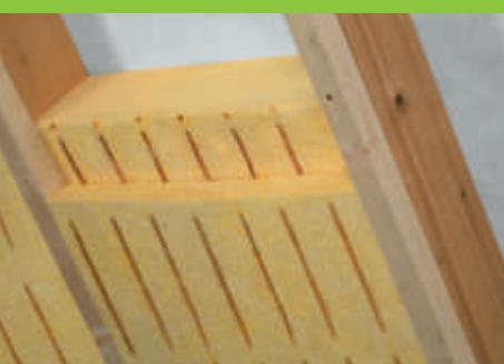
Auch bei mehrlagigem Verlegen kein Durchhängen der Klemmfilze im Gefach
