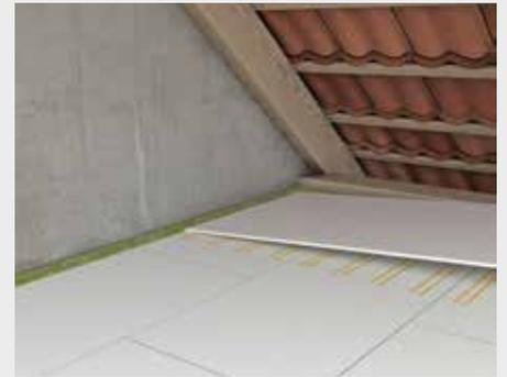
Soll später der Dachboden zum Wohnraum umgebaut werden, verkleben und verschrauben Sie eine Lage **fermacell** Gipsfaser-Platten auf den Dachboden-Elementen\* (aktuelle Verlegehinweise beachten).
