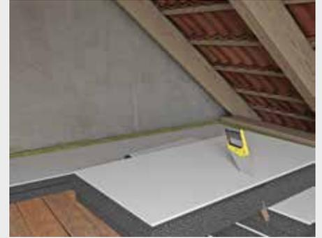
Das jeweilige Endstück der Reihe sägen Sie einfach mit einem Fuchsschwanz auf die passende Länge. Das Reststück ist dann das erste Element für die nächste Reihe.
