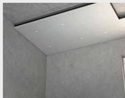
Das jeweilige Endstück der Reihe sägen Sie einfach mit einem Fuchsschwanz auf die passende Länge. Das Reststück ist dann das erste Element für die nächste Reihe. Ist die Fläche fertig verlegt, sollten offene Rand- und Anschlussfugen zur Vermeidung von Wärmebrücken z. B. mit Montageschaum geschlossen werden.
