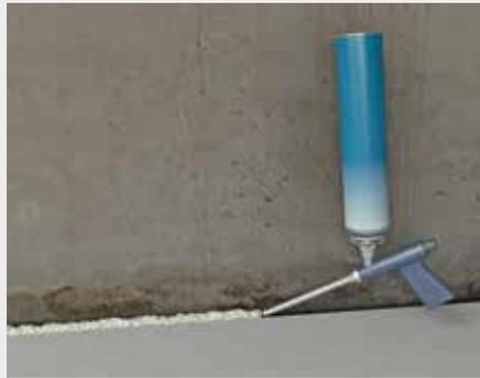
Ist die Fläche fertig verlegt, sollten offene Rand- und Anschlussfugen geschlossen werden, z. B. mit Montageschaum, da sonst Wärmebrücken entstehen könnten.
