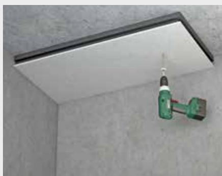
Die Elemente je nach Deckenbeschaffenheit mit mindestens 2 geeigneten Befestigungsmitteln befestigen. Dazu werden die Dübellöcher durch das Element vorgebohrt.
