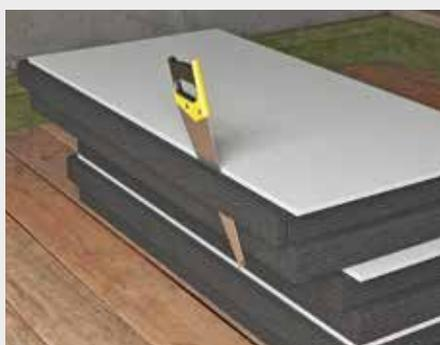
Für die 1. Verlegereihe wird die überstehende Feder längsseitig abgesägt.
