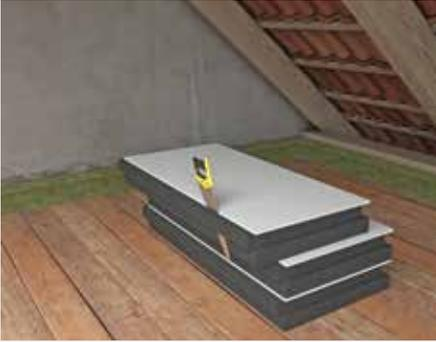
Die Verlegung erfolgt von rechts nach links im schleppenden Verband. Für die 1. Verlegereihe wird die überstehende Feder längsseitig abgesägt.
