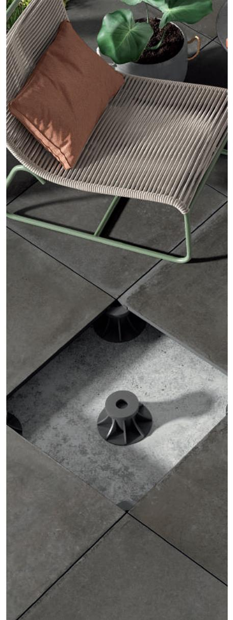
Die Verlegung der SMARTGRIP-Platten auf Stelzlagern basiert auf einem höhenregulierbaren System und stellt einen weiteren Schritt in der Überwindung von Problemen der traditionellen Verlegeweise dar.
