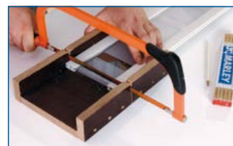
Zuschneiden der Profile auf die benötigte Länge.
