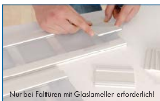
Nur bei Falttüren mit Glaslamellen erforderlich! Abschlussblenden mit doppelseitigem Kleband unten in die gekürzten Glaslamellen einkleben.
