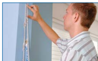
Ausmessen der Türöffnung (Breite und Höhe).
