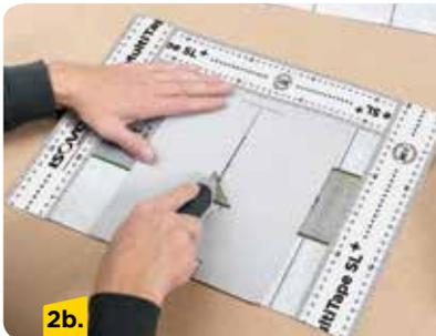
Für die Manschette ein ausreichend großes Folienstück an drei Seiten mit Vario® MultiTape SL+, wie bereits bei anderen Manschetten beschrieben, bekleben. Dazu den Split Liner einseitig abziehen. Schablone auflegen und ausschneiden.
