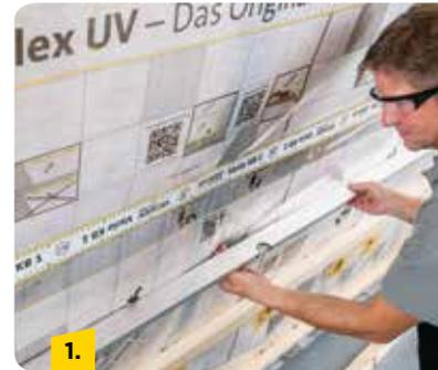
Lattungsverlauf im Bereich der Sparren auf der Folie anzeichnen. Der Abstand der Lattung untereinander sollte bei max. 50 cm liegen. Der Rasteraufdruck auf der Folie dient als Orientierung. Dann Versatz der Sparren mittels Richtlatte überprüfen.
