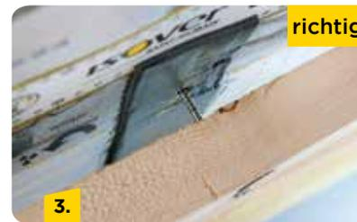
Nun können die Latten und Stellschrauben positioniert werden. Das elastische Schaumband dichtet die Leckage zuverlässig ab.
