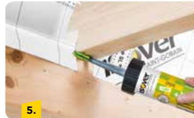
Auch an der Balkenunterseite muss eine Dichtstoffraube gelegt werden.
