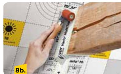
Alle Klebebänder zum optimalen Halt mit Rakele oder einer Gummiwalze fest anrollen.
