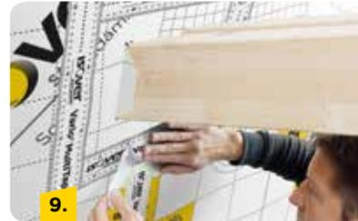
Jeweils die zweite Linier-Spur der Klebestreifen Vario® MultiTape SL+ von der Manschette lösen und die Manschette rundum luftdicht mit der Klimamembran verkleben.
