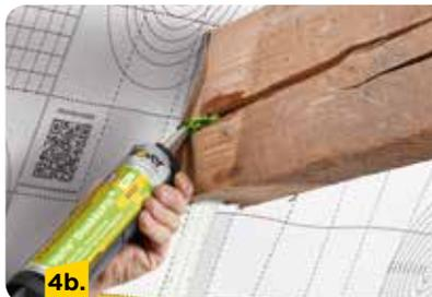
Die Balkenrisse mit reichlich Klebe-Dichtmasse Vario® DoubleFit+ ausspritzen. Dabei die Dichtmasse zur optimalen Abdichtung einige Zentimeter über die Klebestelle hinaus verlängern.
