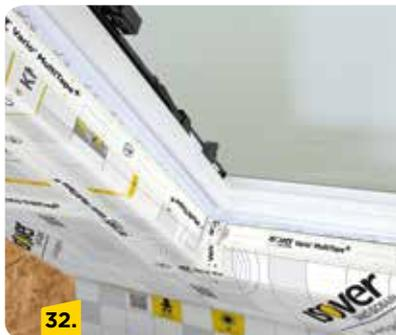
Die Folienschürze am Fenster von Staub und Fett (z. B. mit handelsüblicher Verdünnung) reinigen. Mit Vario MultiTape+ an die Klimamembran anschließen. In den Ecken ist Vario MultiTape SL+ optimal. Anschließend das Klebeband mit einer Hartgummiwalze andrücken.
