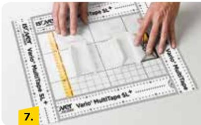
Die Schablone mit den Balkenmaßen auf die vorgefertigte Grundplatte legen und die Klimamembran entsprechend der Schablonenzeichnung Y-förmig einschneiden.
