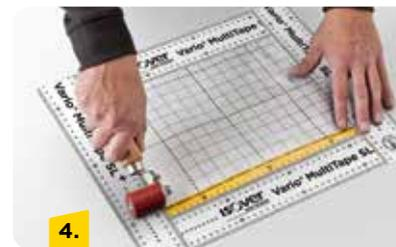
Zum optimalen Halt die Klebebänder mit der Andruckrolle anrollen. Tipp: Grundplatten können in der Werkstatt vorbereitet und auf die Baustelle mitgebracht werden.
