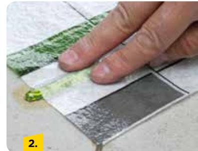
Zum V-förmigen Andichten der Folie mit zwei Fingern entlang der Dichtstoff-Raupe gleiten und seitlich leichten Druck auf die Raupe ausüben. Das Andichten kann auch mit einer Holzschablone erfolgen, die über die Raupe gezogen wird.
