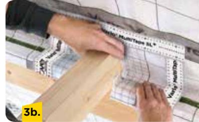
Die Manschette am Balken anpassen und die Folienflügel bündig an die Balkenflanken anlegen.
