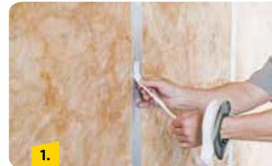
Die Klettstreifen Vario® XtraPatch alle 40 cm auf die fettfreien Metalständer aufkleben. Der Fingerlift erleichtert das Anbringen. Der Streifen ist flach und trägt später im Aufbau nicht auf.
