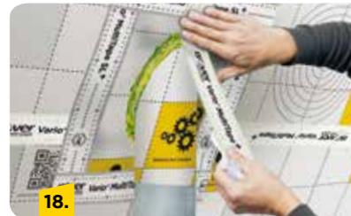
Die offenen Folienlappen der Rohrmanschette an der Vorderseite mit Vario® MultiTape+ verkleben.
