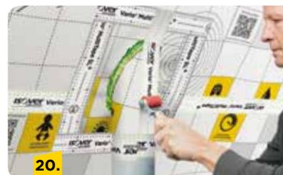
Alle Klebebänder mit Rakel oder Andruckrolle anrollen, um eine optimale Klebehaftung sicherzustellen.
