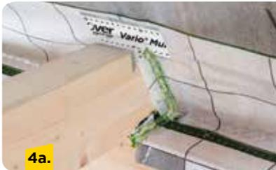
An der Oberseite des Balkens die Folie mit Vario® MultiTape SL+ luftdicht anschließen.
