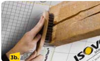
Die Balken an der Klebestelle mit der Stahlbürste gründlich von Staub und Schmutz reinigen. Untergrund mit Primer vorbereiten.
