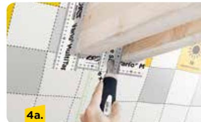
Dann die langen Seiten wie oben beschrieben mit Vario® MultiTape SL+ verkleben. Alle Klebebänder mit einer Gummiwalze anrollen.
