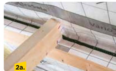
Im Anschluss die eingeschnittenen Folienflügel der Vario® XtraSafe bündig an den Balken anlegen.
