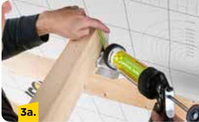
Mit Vario® DoubleFit+ die Klimamembran an den Seiten luftdicht am Balken anschließen. Auch an der Unterseite des Balkens eine Kleberaube mit Dichtstoff setzen.
