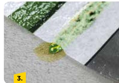
Damit der Dichtstoff optimal luftdicht abdichten kann, muss ein kleiner Hügel aus Dichtmasse unter der Folie stehen bleiben.
