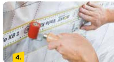
Abschließend alle Verklebungen mit einer planen Gummiwalze anrollen und insbesondere die Kanten dabei fest andrücken. Keine Schaumstoffrolle bzw. gewölbte Rolle verwenden.
