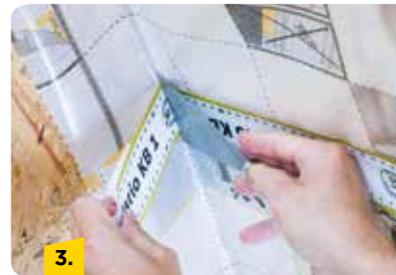
Um eine effektive Eckverklebung zu erreichen, das Klebeband mit einem Spachtel sorgfältig in die Ecken drücken. Zur sicheren Verarbeitung immer nur so viel Liner des Klebebands abziehen, wie gerade benötigt wird.
