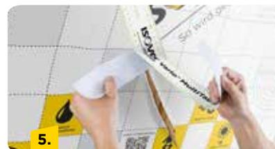
Ausgerissene Tackerlöcher oder Beschädigungen der Folie mit Klebeband verschließen.
