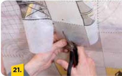
Mit der Folienschürze an den unteren Fensterecken wie oben vorgehen. Hier wird die Folie nur von unten senkrecht eingeschnitten.
