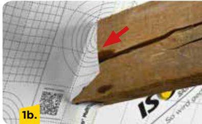
Den Folienausschnitt für den Balkenanschluss im Altbau X-förmig ausführen. Beim Verarbeiten darauf achten, dass die Foliensaschenkel zur Raumseite zeigen.
