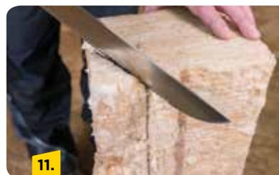
Mit dem Dämmstoffmesser sorgfältig entlang der Markierungen schneiden.
