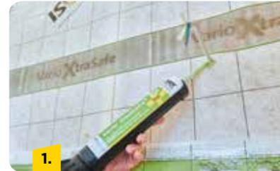
Die Kabelzwischenräume zur Abdichtung mit der Klebe-Dichtmasse Vario® DoubleFit+ aus-spritzen.
