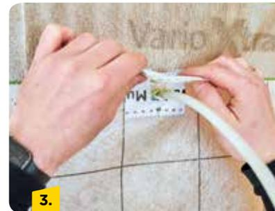
Von einem Streifen des Klebeband Vario® MultiTape SL+ den Liner einer Spur lösen und das Band direkt unter den das Kabelbündel kleben. Danach den Liner der zweiten Spur lösen, kabelbreit mit dem Cutter einschnei-den und ankleben.
