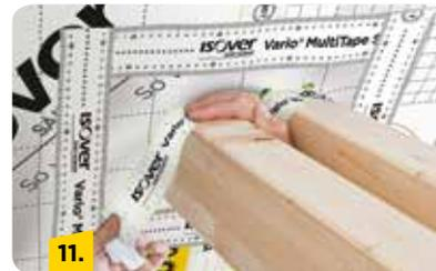
Die aufgestellten Folienlaschen mit einzelnen Streifen Vario® MultiTape+ am Balken verkleben. Ebenso die eingeschnittene Naht der Manschette verkleben.
