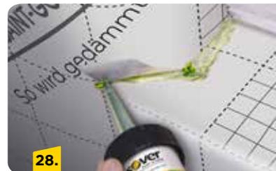
An den Einschnittstellen der Eckpunkte ebenfalls Dichtstoffpunkte setzen.
