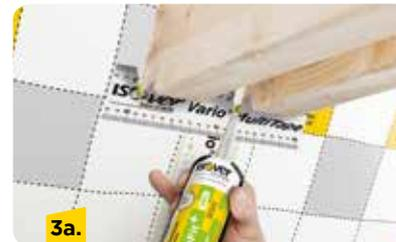
An alle Balkenkanten etwas Klebe-Dichtmasse Vario® DoubleFit+ spritzen.
