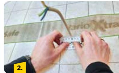
Alle Kabel zusammen-fassen und mit Klebeband bündeln. Rings um das Kabel-bündel reichlich Klebe-Dichtmasse Vario® DoubleFit+ zur Abdich-tung auftragen.
