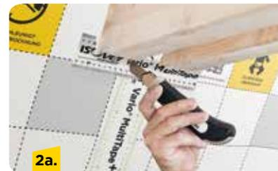
Die zweite Liner-Spur des Klebebands lösen und am Balken festkleben. An den Balkenkanten gemäß der Abbildung mit einem Cutter einschneiden und festkleben.
