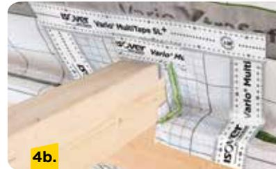
Die Folienflügel mit der Klebe-Dichtmasse Vario® DoubleFit+ andichten und mit Vario® MultiTape SL+ luftdicht verkleben.
