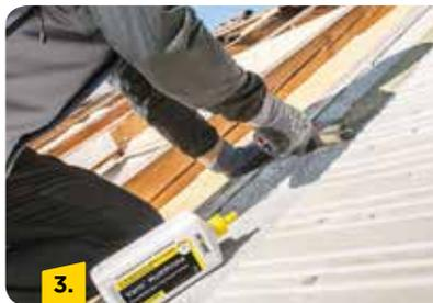
Tipp: Durch die gelbe Einfärbung werden bereits behandelte Flächen gekennzeichnet. Die rechteckige Form sorgt auch bei Schrägen für Stand-sicherheit.
