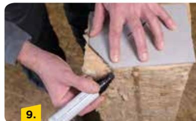
Den passenden Dämmstoffstreifen (H x B) zuschneiden. Die Schablone auflegen und die Schräge mit einem Filzstift antragen.
