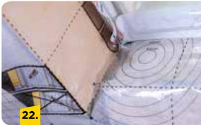
Zuerst die beiden Folienstücke der Breitseiten der Klimamembran über die Dämmung führen. Danach die seitlichen Streifen an der Laibung faltenfrei verlegen. Überstehende Ecken kürzen.
