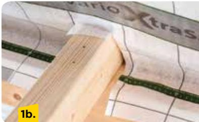
Variante b: Ist ein schneller, grober Zuschnitt um den Balken bereits erfolgt, erleichtert eine Manschette den luftdichten Anschluss.
