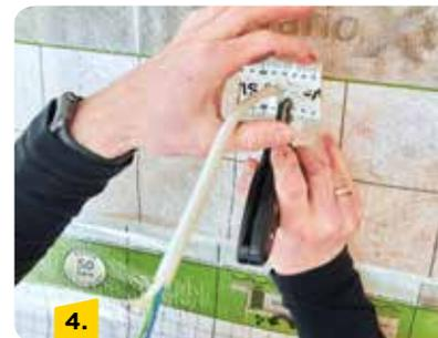
Anschließend einen weiteren Klebestreifen Vario® MultiTape SL+ von oben an das Kabelbündel kleben und dann wie in 3. beschrieben verfahren.
