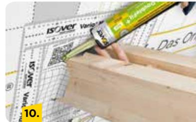
An alle Balkenkanten je einen kleinen Dichtpunkt der Klebe-Dichtmasse Vario® DoubleFit+ setzen.
