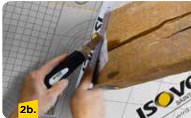
Die dreieckförmigen Folienschenkel parallel zur Dachneigung auf eine Länge von 2,5 cm einkürzen. So ist die luftdichte Verklebung mit der Folie und dem Balken sichergestellt.
