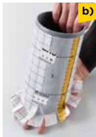
Das Rohr in der Manschette ca. 3 cm zurückziehen (a) und den Überstand so einschneiden, dass kleine Laschen entstehen (b).
