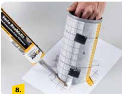
Das Rohr aufstellen und die Laschen nach außen biegen. Eine Raupe der Klebedichtmasse Vario® DoubleFit+ umlaufend aufbringen. Zum Schutz der Arbeitsfläche kann Papier untergelegt werden.
