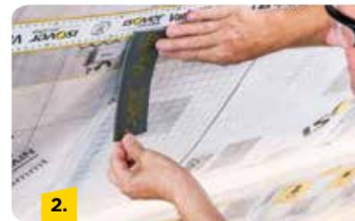
Vario® AntiSpike mit dem Cutter in ca. 10 cm lange Streifen schneiden und mittig über den Sparren kleben. Bei vielen Sprüngen in der Konstruktion das Nageldichtband durchgängig verlegen.
