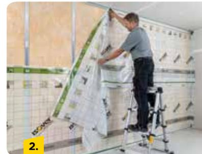
Erste Folienbahn Vario® XtraSafe von unten ausgehend ankletten. Die zweite Folienbahn von oben über die erste Bahn ankletten und den überstehenden Rand bis auf 10 cm Überlappung abschneiden. Dazu Strichmarkierung verwenden.
