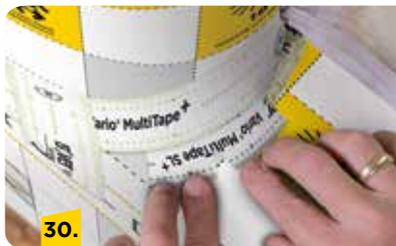
Zum Schutz der Eckpunkte zusätzlich einen kleinen Streifen Vario® MultiTape SL+ zuschneiden. Dann nur von einer Seite etwas zur Mitte hin einschneiden und über die Dichtstoffpunkte kleben.
