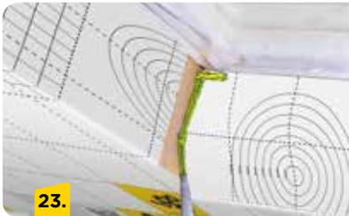
Die Folienstücke an den beiden Längsseiten der Fensterlaibung im unteren Eckbereich wieder etwas zurück schlagen und im Überlappungsbereich eine Dichtstoffraupe (ca. 8 - 10 mm) auftragen.
