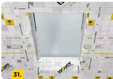
Nun die zuvor längs angebrachten Folienstreifen in der Dachfläche mit Vario® MultiTape+ verkleben. Das Klebeband hierbei positionieren und mit einer handelsüblichen kleinen Hartgummiwalze anrollen.
