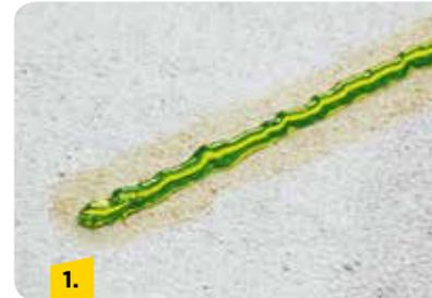
Mit der bereits V-förmig angeschnittenen Kartuschenspitze (siehe Seite 12) eine voluminöse Dichtstoff-Raupe auf die geprimerter Fläche aufspritzen und die Folie darüberlegen.
