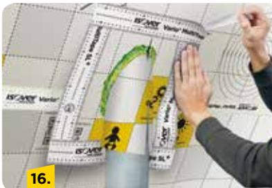
Die Manschette von hinten exakt um das Rohr führen. Die zweite Liner-Spur des Klebebandes Vario® MultiTape SL+ lösen und die Manschette rundum luftdicht auf der Klimamembran verkleben.
