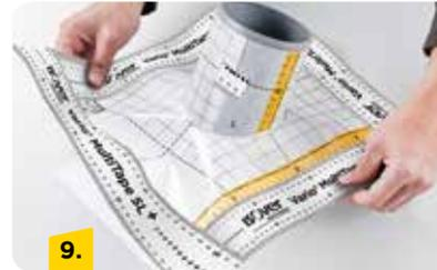
Die vorbereitete Foliengrundplatte mit der ausgeschnittener Rundung über das Rohrstück ziehen.
