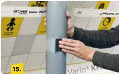
Die angezeichnete Klebestelle mit Verdünnung reinigen und Oberfläche mit Schleifpapier aufrauen. So ist sie für eine optimale Klebeverbindung zwischen Klebeband und Rohr vorbereitet.
