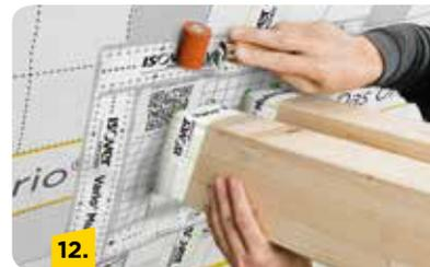
Zum optimalen Halt alle Klebebänder mit Rakel oder Andruckrolle anrollen.
