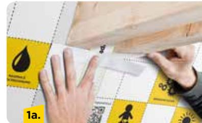
Das Klebeband Vario® MultiTape SL+ zuerst an den kurzen Seiten mit dichtem Anschluss an den Balken auf die Folie kleben. Nur eine Liner-Spur abziehen.
