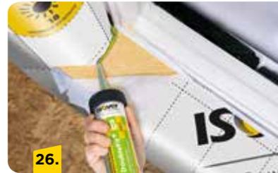
In die Ecken, siehe (22.), am Sturz großzügig z.B. Vario® DoubleFit+ Dichtstoff setzen und entlang der Überlappung auftragen.
