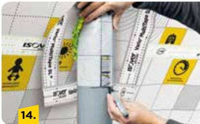
Wird ein PVC-Lüftungsrohr abgedichtet, muss die Klebestelle aufgeraut werden. Dazu die Unterkante der Manschette vor dem Verkleben am Rohr anzeichnen.
