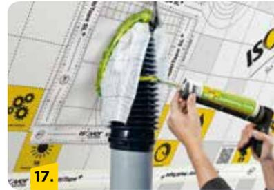
Wird ein Flex-Anschlussrohr abgedichtet, muss ausgeschlossen werden, dass Luft entlang der Vertiefungen entweicht. Zur Abdichtung reichlich Klebe-Dichtmasse Vario® DoubleFit+ einmal umlaufend in die Spirale einbringen.
