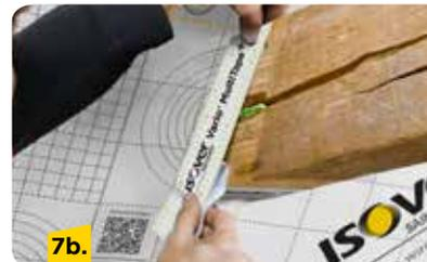
Dann zum sicheren Abdichten vier zusätzliche Streifen Vario® MultiTape+ um den Balken kleben.
