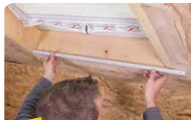
Seitlich Dämmstoffplatten (z. B. Integra UMP-032) für die Laibung passgenau in maximal möglicher Dicke zuschneiden und fixieren. Dann Maß + Klemmzuschlag (Empfehlung 1 cm) für den Dämmstoffkeil nehmen.
