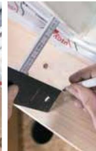
Mittels Winkel das Maß aus (1.) winkelrecht zum Sparren verlängern. Entsprechend der Angaben des Fensterherstellers Eckpunkte für den späteren Übergang zu Sturz/Brüstung anzeichnen – hier (z. B.) bei 8 cm, gemessen in der Innenfutternut des Blendrahmens.
