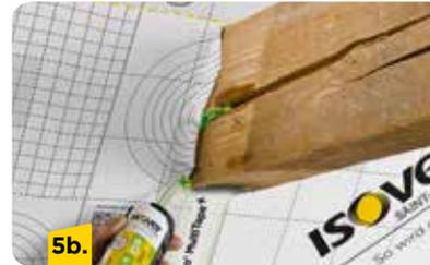
In alle Ecken Dichtpunkte mit der Klebe-Dichtmasse Vario® DoubleFit+ setzen.
