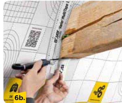
Die einzelnen Folienschenkel mit Vario® Multi-Tape SL+ verkleben. Dazu eine der Klebespuren dicht am Balken auf die Folie kleben. Den Liner von der zweiten Klebespur lösen, mit Überstand festkleben, an den Balkenkanten einschneiden, umlegen und faltenfrei ankleben.
