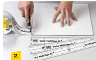
An der Längsseite der Schablone vier Klebestreifen Vario® MultiTape SL+ abmessen und zuschneiden.
