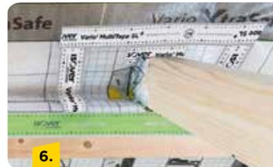
Nun erfolgt der Anschluss der Klimamembran an der Mittelpfette mit dem Kleband Vario® XtraTape.
