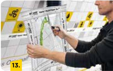
Um die Rohrdurchdringung vollständig abzudichten, die vorgefertigte Manschette entlang der langen Seite aufschneiden.
