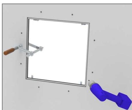
Rahmen verschrauben und beiliegende Schutzkappen rückseitig aufstecken.
