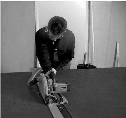
**3.2** Bei langen Schnitten sollte eine Führungsschiene verwendet werden, um eine exakte Bearbeitung gewährleisten zu können. Vorsicht beim Sägeschnitt –Eingang und Ausgang. Auf richtiges Sägeblatt achten (siehe Werkzeughinweise). Bei der Verwendung einer Stichsäge Pendelhub ausschalten.
