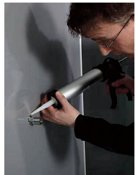
3.20 Durchführungen mit essigsäurefrei vernetzendem Naturstein-Silikon abdichten
