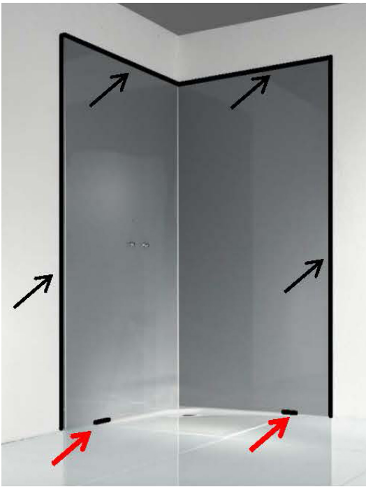
3.21 Designplatten rundum zur Wand hin mit essigsäurefrei vernetzendem Naturstein-Silikon abdichten.
