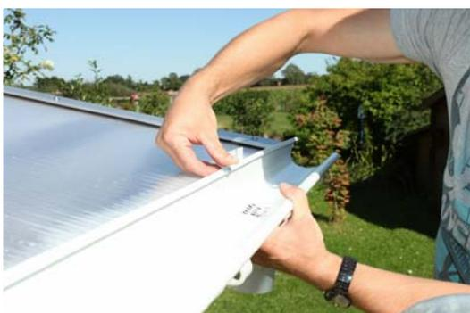
Bohren Sie an dem gewünschten Ende der Halbrundrinne (C160-Längen) ca. 15 Löcher (Ø 9 mm) für den Wasserablauf. Anschließend legen Sie die Halbrundrinnen zusammen mit dem Rinnenablaufstutzen (C164-01/02) in die Rinnenhalter. Nach dem Einhängen müssen ggf. die Rinnen nachgebogen werden.
