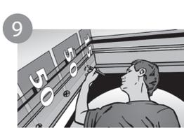
9 Markieren Sie die Punkte für Dübelbohrungen im Mindestabstand von 15 cm aus der Ecke heraus und maximal 50 cm zwischen den einzelnen Bohrungen.
