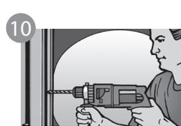
10 Bohren sie die Dübellöcher. Die Fuge zwischen dem Elementrahmen und dem Mauerwerk im Bereich der Befestigungspunkte mit Klötzchen hinterfüllern.
