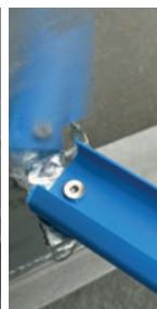
Montarea șinelor de bază piese de racordare
