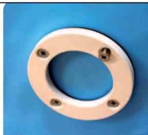
3. Schneiden Sie den Ausschnitt mithilfe des Flansches zu.
