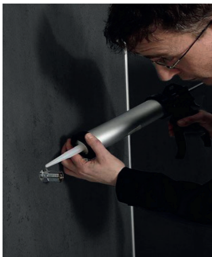
3.17 Durchführungen mit essigsäurefrei vernetzendem Naturstein-Silikon abdichten.
