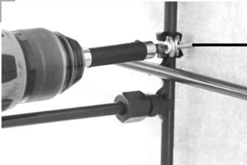
**Bohrloch markieren, bohren und Kippsicherung beidseitig anschrauben. Wenn nötig, Distanzhalter verwenden. Wichtig: Bei Bedarf entsprechend dem Untergrund Dübel setzen.**
