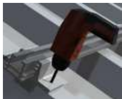
Abbildung 100 Klemme verbohren
