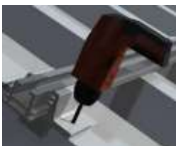
Abbildung 68 Klemme verbohren
