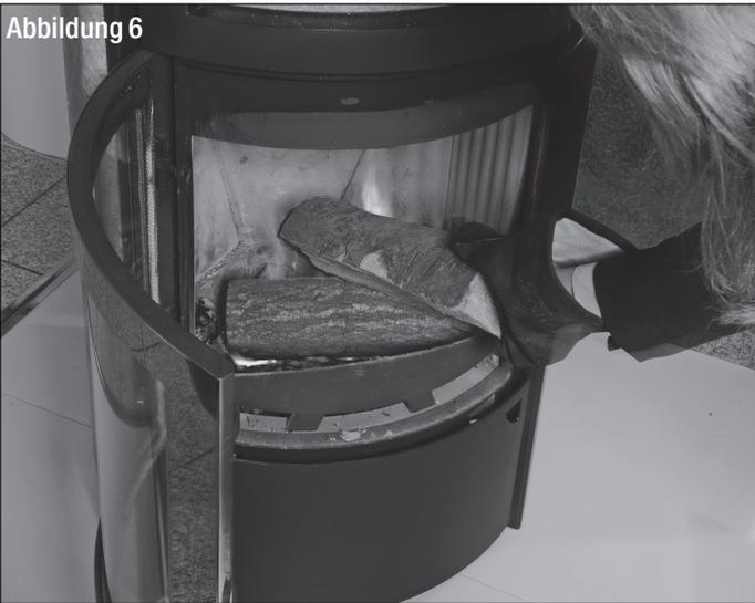
Sind auch diese Holzscheite rundherum angebrannt, sollten Ofen und Abgassystem weitgehend die Betriebstemperatur erreicht haben. Jetzt können Sie den Primärluftregler schließen und die Verbrennung hauptsächlich über den Sekundärluftregler regeln (Abb. 7).
