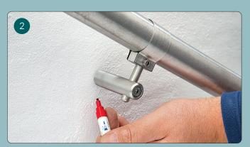
Montieren Sie die Handlaufkonsolen in gleichmäßigem Abstand von 80 bis 120 cm (einfach aufs Rundrohr stecken) und zeichnen Sie die Bohrlöcher ein.
