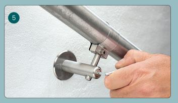
Schließlich die Konsolen samt Handlauf ansetzen und mit Inbusschlüssel festziehen.
