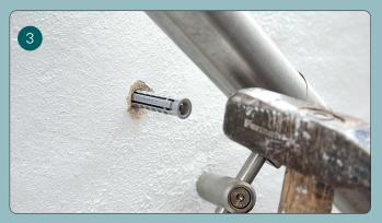
Bohren Sie Löcher und schlagen den Dübel ein. Hier kann ein 10er-Nylondübel verwendet werden.
