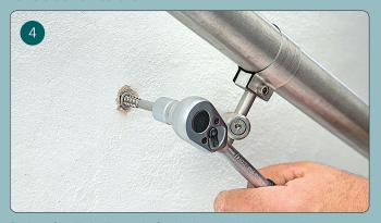
Drehen Sie die beiliegende Stockschraube ein. Verwenden Sie entweder eine M8-Mutter oder einen Torx Bit T25.
