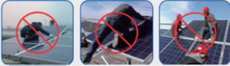
Stehen oder sitzen Sie beim Einbau oder bei der Reinigung nicht auf den Modulen und treten Sie auch nicht darauf.
