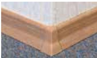
Drücken Sie die Sockelleiste fest auf den Clip nach unten. Ggf. kann ein vorsichtiger und leichter Schlag unter Zuhilfenahme eines Schlagklotz und eines Hammers von oben auf die Leiste, für die passgenaue Arretierung sorgen. Beachten Sie bitte das die Sockelleiste hierbei nicht beschädigt wird.
