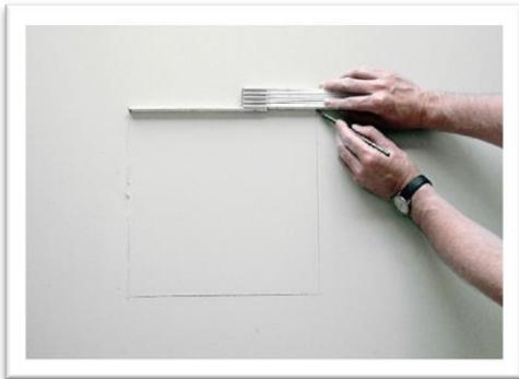
1. Ausschnitt anzeichnen und aussägen (Breite 5 mm und Höhe 20 größer als Außenmaß des Einbaurahmens).
