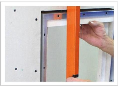
3. Rahmen in Öffnung einsetzen und ausrichten.
