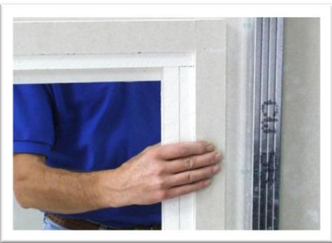
5. Leisten (kurze oben u. unten, lange seitlich) an der Rückseite bündig am Rahmen anschlagen und von vorn verschrauben.
