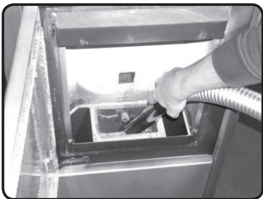
Abb. 14f: Reinigung Brennraumbehälter
