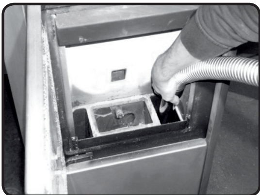
Abb. 14g: Reinigung untere Brennkammer
