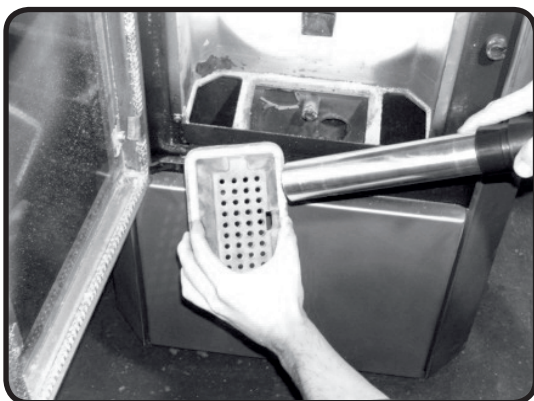
Abb. 14b: Reinigung der Luftöffnungen mit einem Staubsauger
