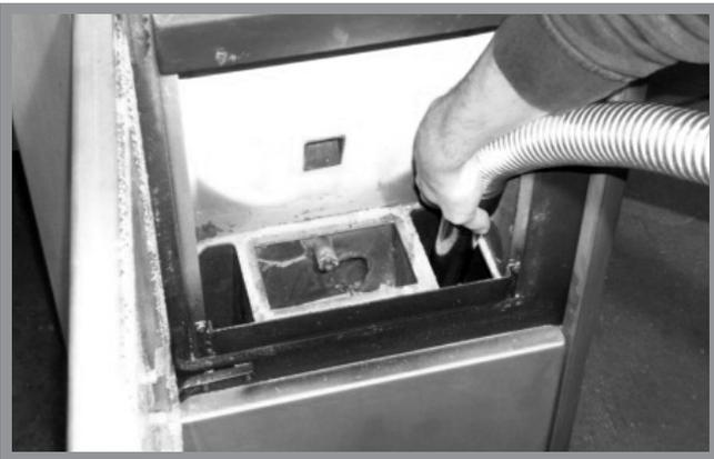
Abb. 12g: Reinigung untere Brennkammer
