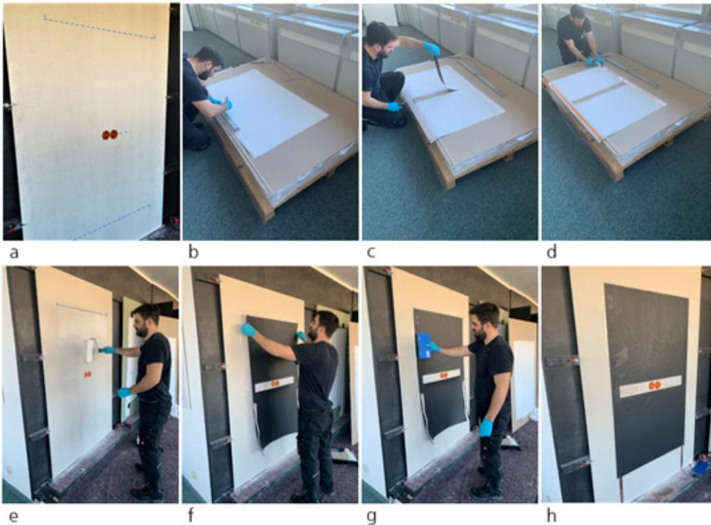
Abbildung 12: Installation der **eThermoHeld •FLEX•** Heizfläche mit Aussparung
