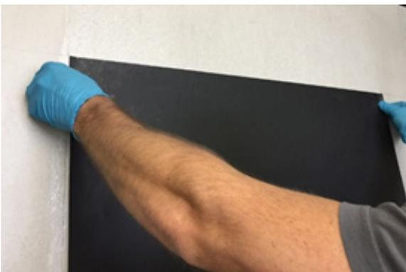
Abbildung 5: Anlegen der eThermoHeld •FLEX• Heizfläche an Markierung, schwarze Seite nach vorne
