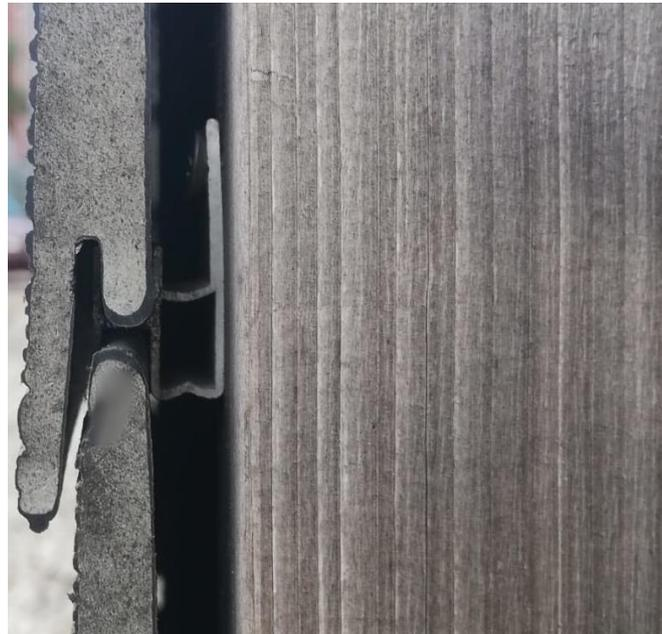
\* Nutzen Sie zur Verschraubung des Clips mit der Unterkonstruktion eine zugelassene Schraube mit Holzgewinde, z.B. M4x20 mm. Die Schraubenlänge- und Stärke hängt von der zu erwartenden Windlast ab. Die beiliegende Schraube 13 mm nutzen Sie bei Bedarf zur Fixierung des Profils im Clip.
