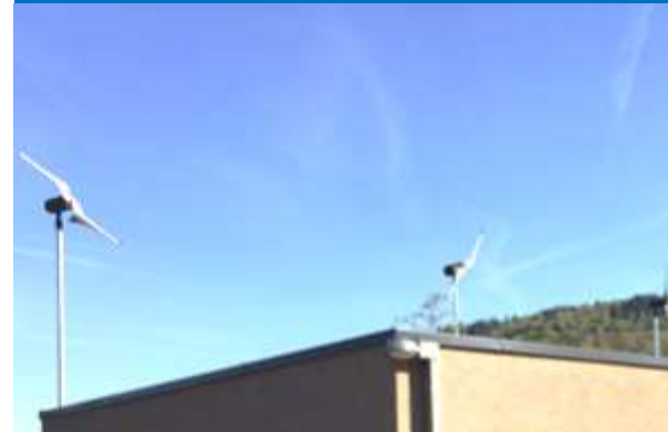
Flanschmontage am Flachdach
