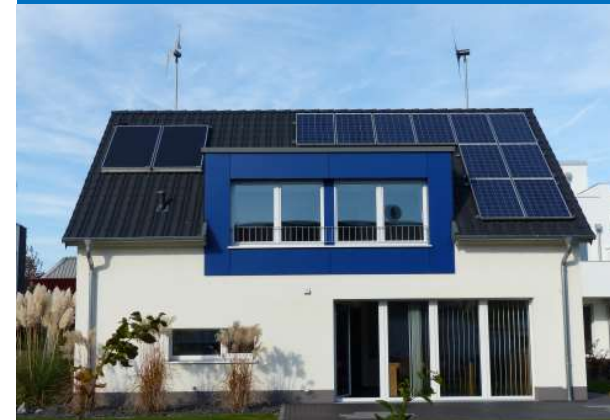
Entkoppelte Aufdachmontage unter den Ziegeln
