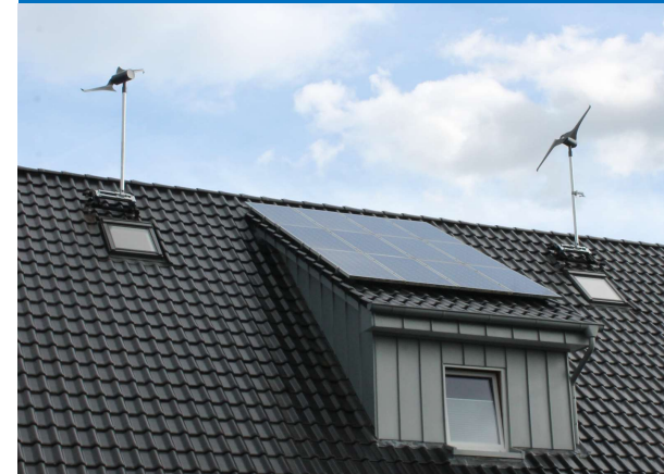
Entkoppelte Aufdachmontage auf Solarschiene (vgl. S. 24)
