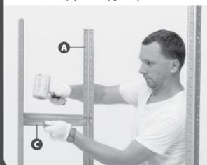
**10** Pokračujte v propojení dalších tří podlaží se stojinami **A** ve stejné výšce, jako jsou umístěny krátké nosníky **C**.
