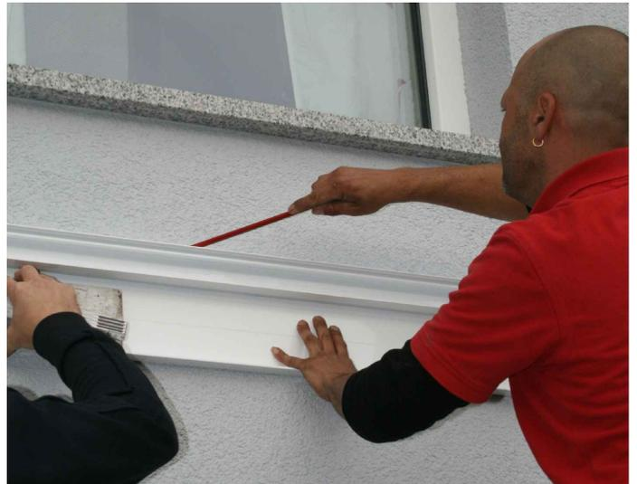
Bohren Sie die Löcher in der Wandpfette (Abstand ca. 40cm) mit einem Metallbohrer vor. Halten Sie die Pfette an die Hauswand und richten sie mit der Wasserwaage aus. Zeichnen Sie danach die Bohrlöcher an und bohren diese entsprechend der Angaben des Dübelherstellers. Montieren Sie die Wandpfette mit dem entsprechenden Befestigungsmaterial (z.B. Injektionsankern M12).
