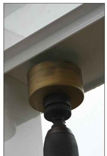
Mit einer Bohrkronen (Durchmesser 68-70mm) bohren Sie jetzt den Anschluß für das Fallrohr. Es kann sowohl neben als auch im Pfosten verbaut werden. **Bitte beachten Sie dabei den Versatz in der Rinnenpfette (siehe Detailzeichnung) sowie den Abstand der Clipphalter für das Fallrohr zum Pfosten ! (ca. 2cm)**
