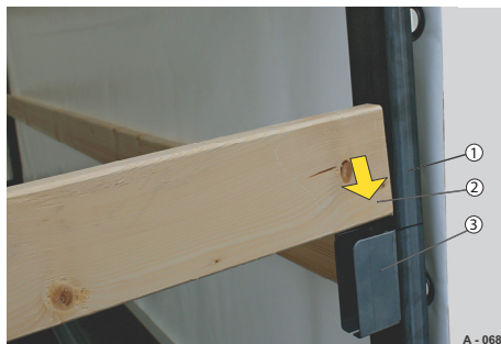
Abb. 79 Einstecklatte einstecken, z.B. HT
