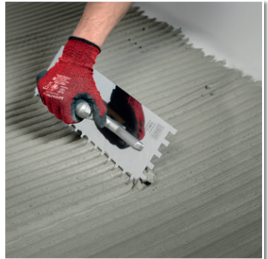
Gleichmäßiger Auftrag von Fliesenkleber.
