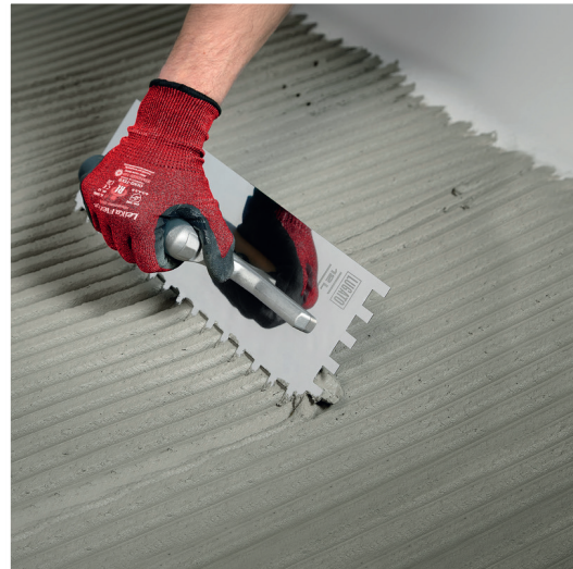
Gleichmäßiger Auftrag von Fliesenkleber.
