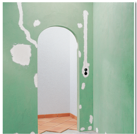
Rissverschluss mit GLATTE SACHE.
