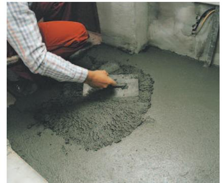
Mit PCI Dichtungsmittel können wasserundurchlässige Estriche und Putze hergestellt werden.
