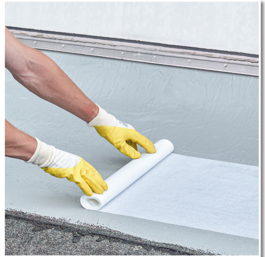
ABDICHTUNGS-VLIES zur norm-konformen Abdichtung mit PROTEKT Flüssigkunststoffen.
