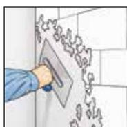
**1.** Der Untergrund muss trocken, tragfähig, sauber und glatt sein. Alte Tapeten und nicht haftende Beschichtungen entfernen. Raue Untergründe mit gipshaltigen Spachtelmasen glätten. Durch geeignete Grundiermittel für einen gleichmäßig saugenden Untergrund sorgen.
