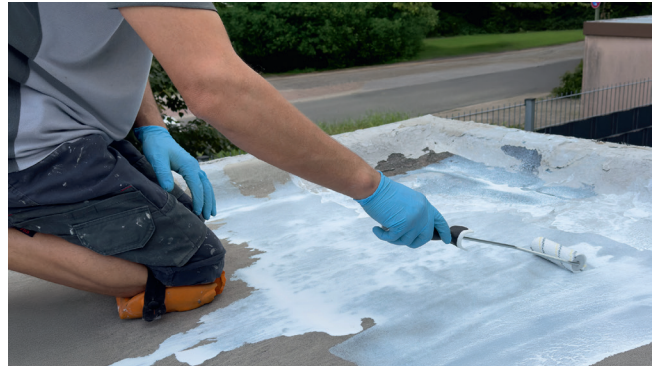
Auftrag der Grundierung
