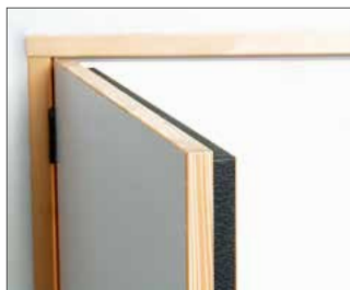
Brandschutzmaterial in der Tür
