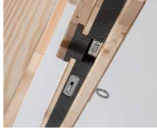
Brandschutzmaterial im Deckel
